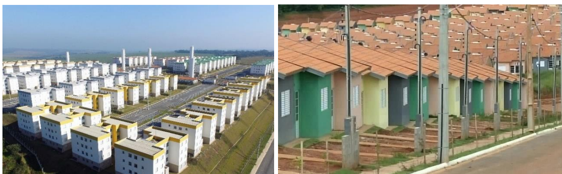
Figura 3. a) Conjunto habitacional multifamiliar em Sorocaba-SP, com densidade de 54 unidades/ha. Crédito: Emerson Ferraz. b) Conjunto habitacional unifamiliar em Itapeva-SP, com densidade de 25 unidades/ha.
