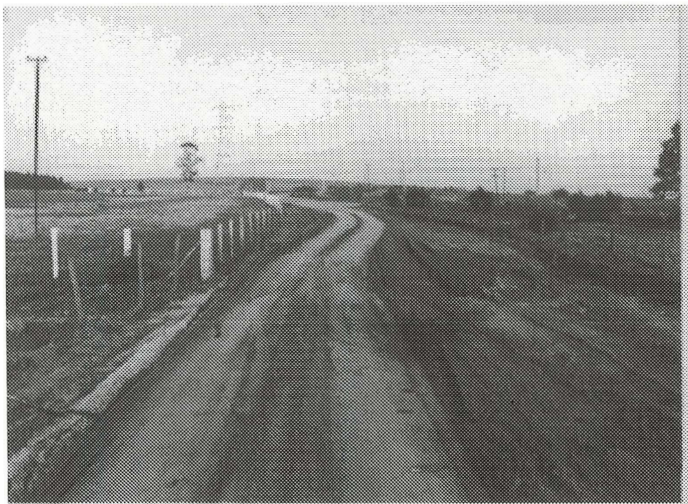
Figura 6 - Trecho de estrada de terra caracterizado como piso ruim.
