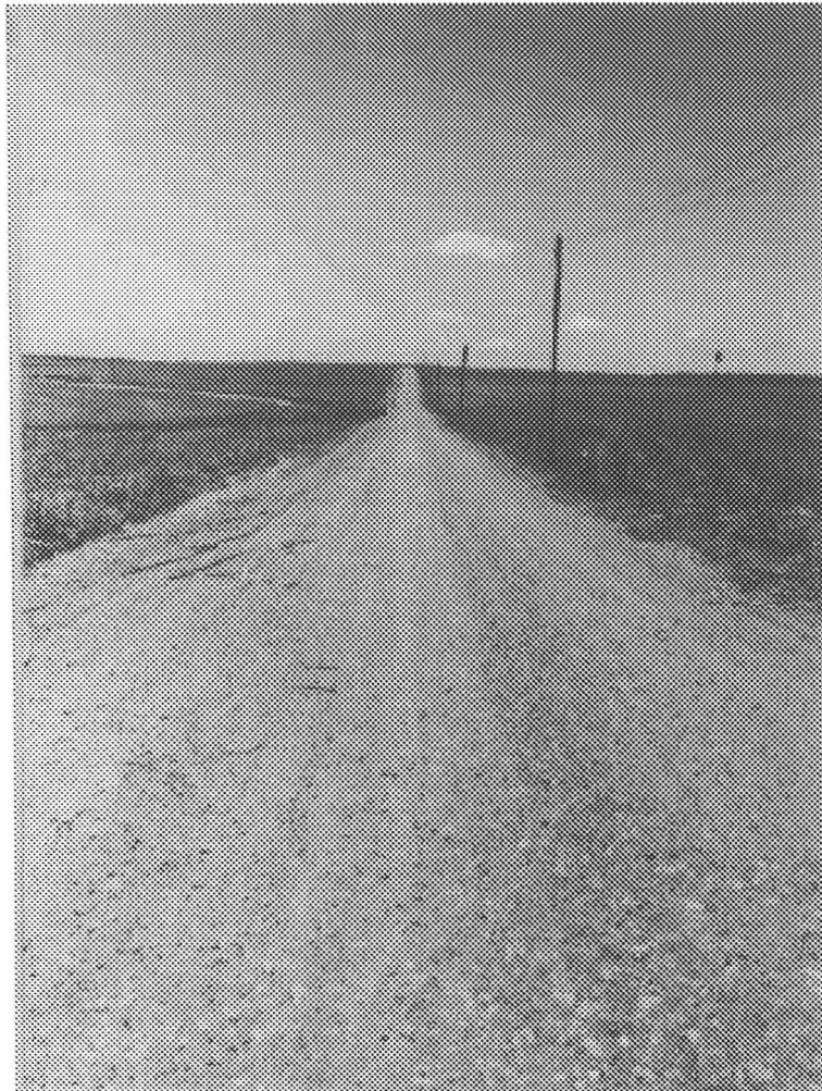
Figura 8 - Trecho de estrada de terra caracterizado como piso bom.
