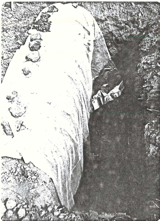
Figura 2. Colocação do filme plástico.
