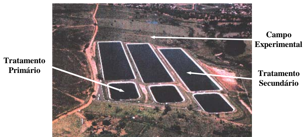
Figura 3 - Lagoas de estabilização operadas pela Sabesp em Lins (SP)
