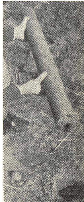
Fig. n. 3 — Dispositivo para retirada de água da cavidade
