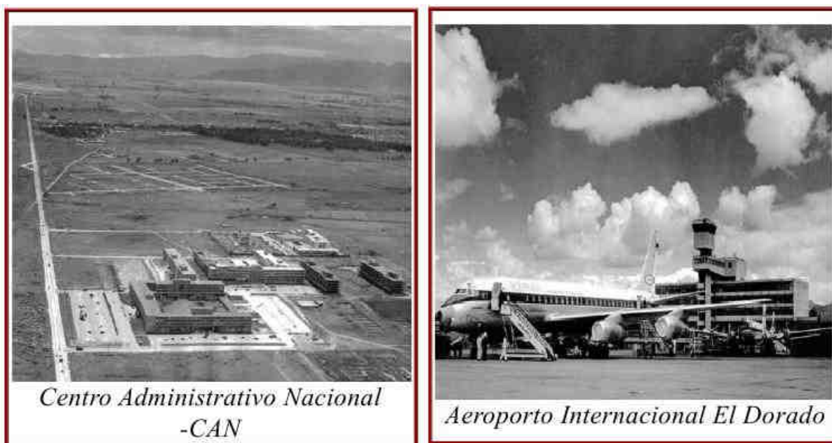
Figura 29 Obras públicas durante a ditadura militar.
