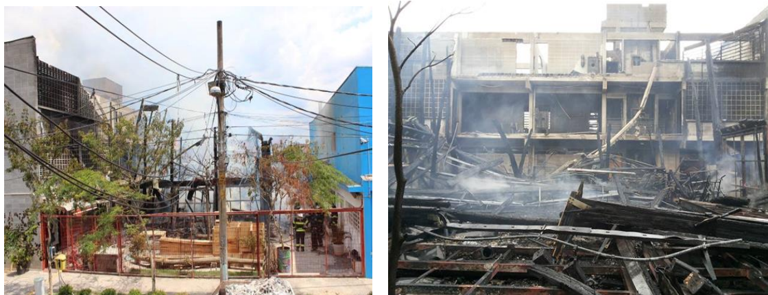
Figuras 10 e 11: No dia 24 de janeiro de 2014, partes das instalações do Alana no Jardim Pantanal incendiaram-se. O incêndio atingiu quase todas as instalações do Instituto Alana. (Fonte: Instituto Alana, 2014).
