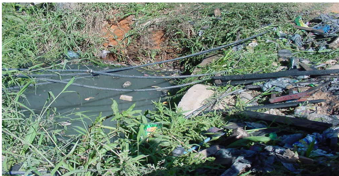
Figura 1. Jardim Pantanal. Ligações Clandestinas de Água. Fonte: Instituto Alana.
