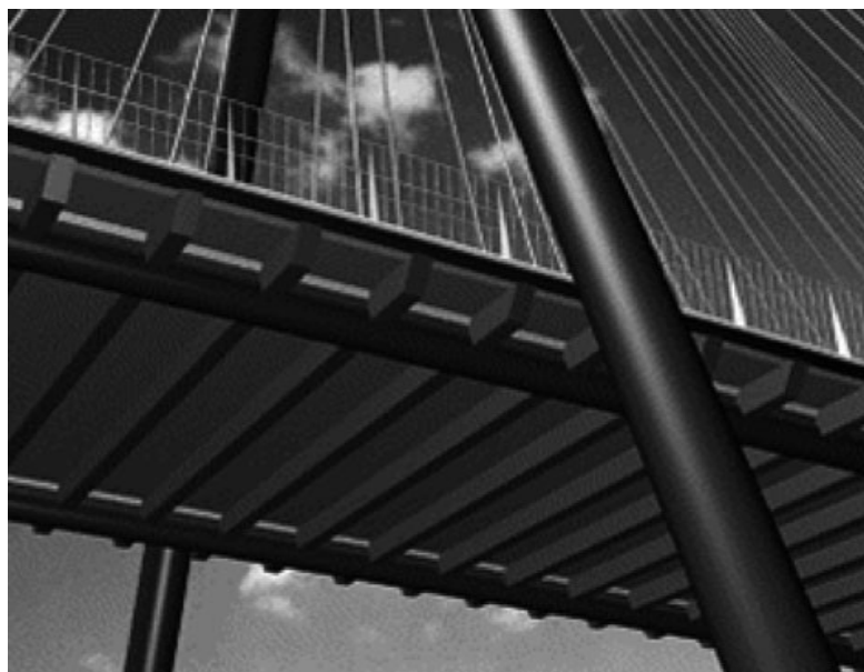
Figura 13: Detalhe inferior do quadro de decks
